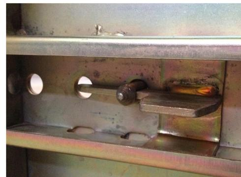
La unión entre paneles se realiza mediante un bulón y cuña incluidos en la placa para evitar su pérdida.
